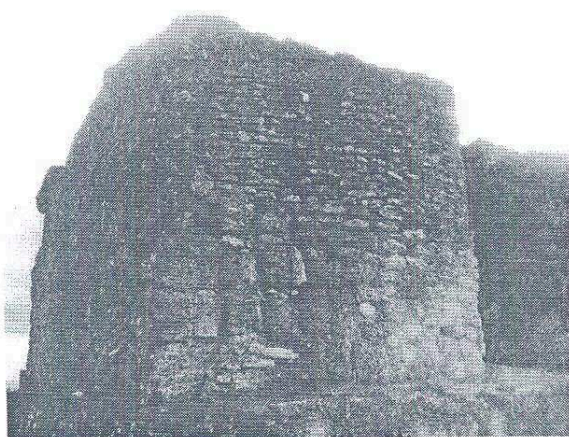
Foto 7. Edificio 216, esquina noreste en el templo, luego de los trabajos efectuados
